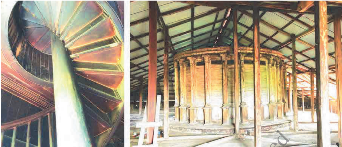
ပုံ(၉) သာကဝန်သစ်သားကျောင်းအတွင်းရှိ ကြောင်လိမ်လှေကား နှင့် ဓမ္မိကာကြက်အတွင်းပိုင်းပုံ
